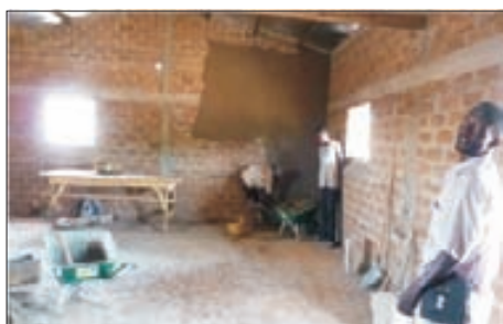
Des travaux de finition intérieure du Kiosque des jeunes en géobéton
