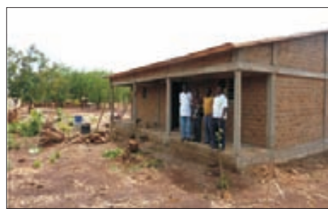
Vue extérieure du kiosque
