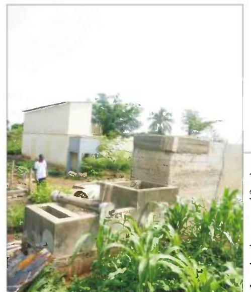
Les latrines en réfection
