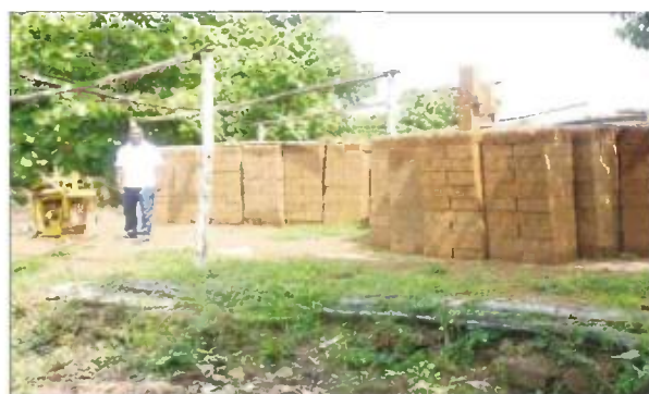
Les briques géo béton prêtes pour la construction du kiosque de jeunes
