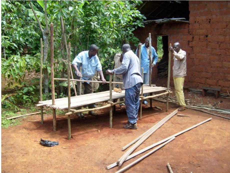
Une étape importante qui est la prise des mesures et l'implantation
